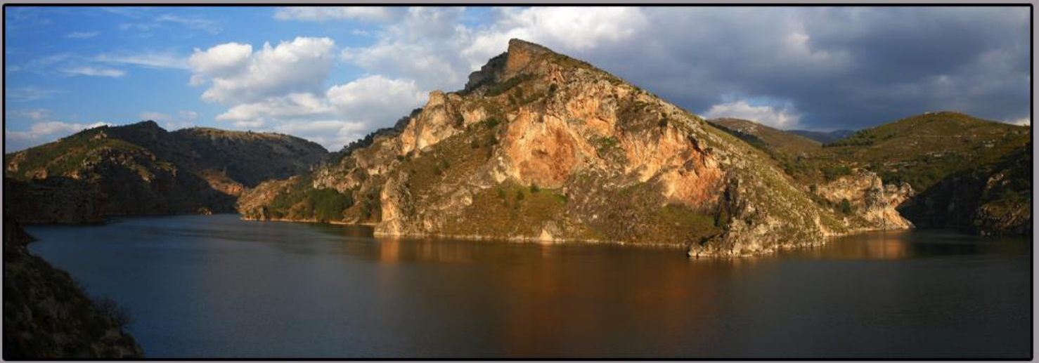
Zona cercana a la presa, con el tajo calizo iluminado por el sol
